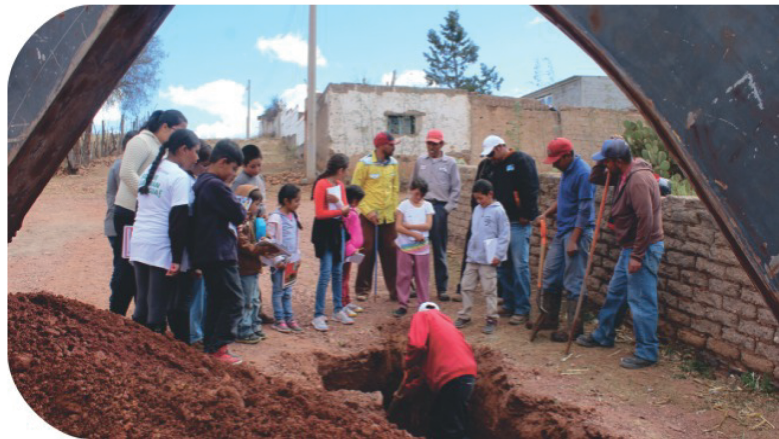
Guardianes del Agua de Nueva Alianza asisten a reparación de fuga.
