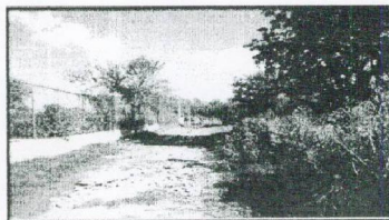
PRINCIPAL ACCESO A CÁRCAMO 4 DE AGUAS NEGRAS 7 JULIO 2010
