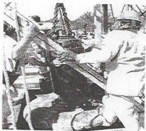
INSTALACIÓN DE LA BOMBA 1 DEL CARCAMO DE AGUAS NEGRAS LAGUNAS
