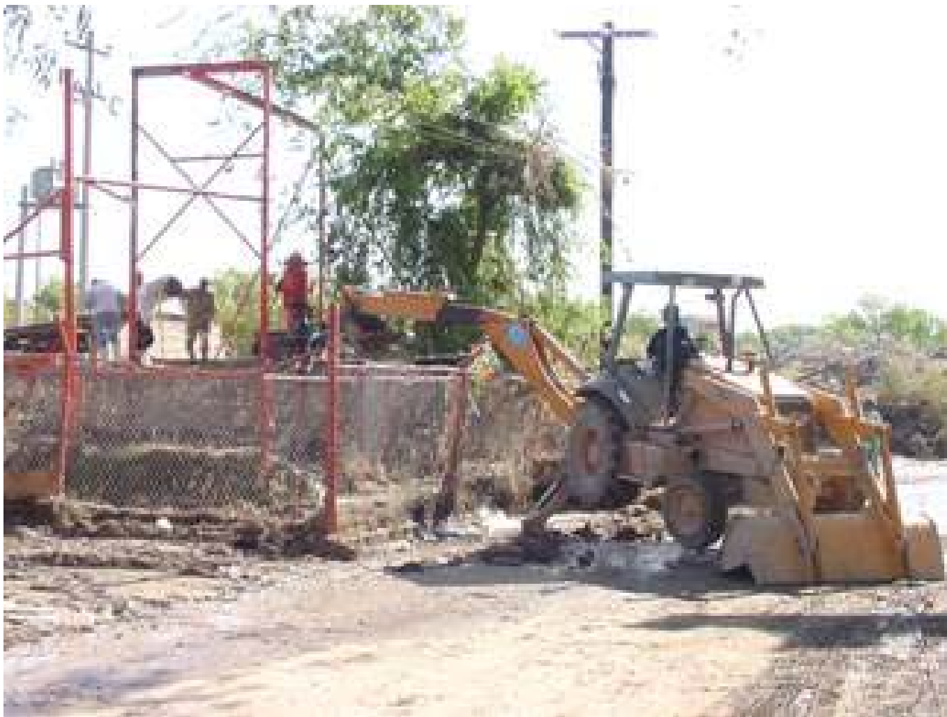
Limpieza y desazolve del Cárcamo de aguas residuales de la Nogalera en Villa de Fuente 14 de Abril del 2004
