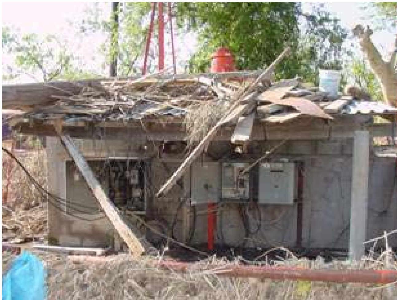
Afectación a la subestación eléctrica en el Carcamo de la Nogalera en Villa de Fuente
