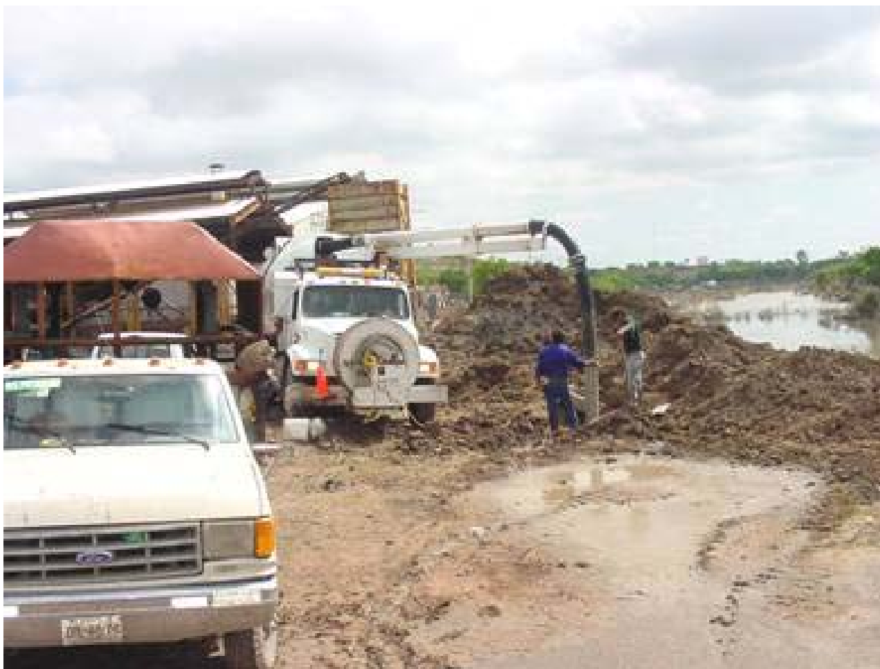
Desazolve de Alcantarrilla Colector Salinas, frente LABASA 09 de Abril 2004
